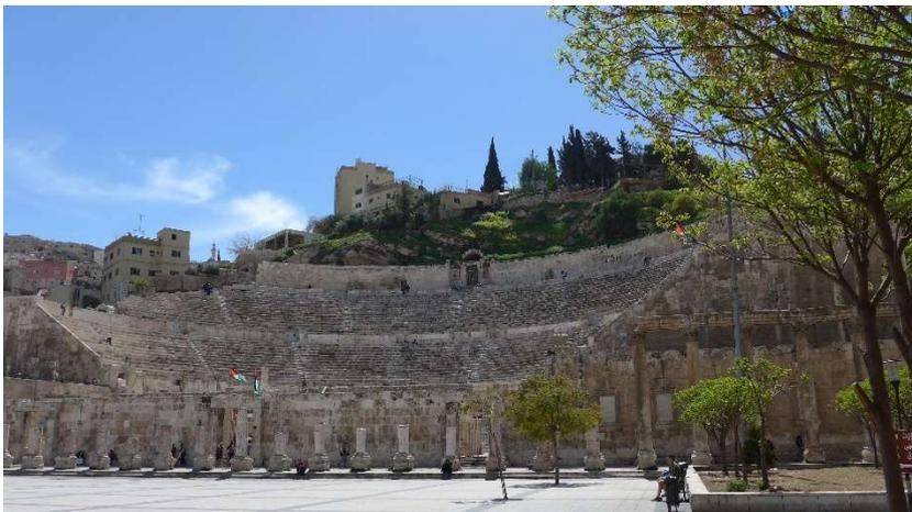
8 Aufgänge erschließen das im 2 Jh. n.C. entstandene Bauwerk, welches Plätze für 6000 Besucher bietet. Geschickt nutzten die Erbauer den Hang des natürlichen Hügels für die tragende Konstruktion; äußerst imposant!
